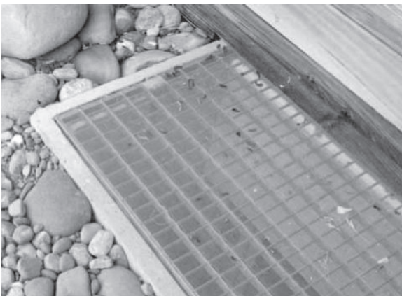
Abb. 12 Mit feinem Gitter bespannter Lichtschacht
