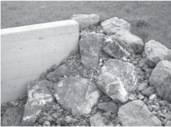
Abb. 8 Mit Steinen ausgebildeter Lichtschacht
