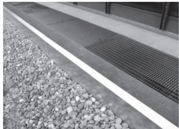
Abb. 13 Absperrblech gegenüber Gefahrenbereich
