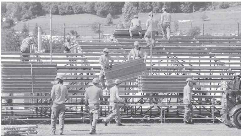
Aufbauarbeiten am Nordwestschweizerischen Schwingfest in Lausen.
